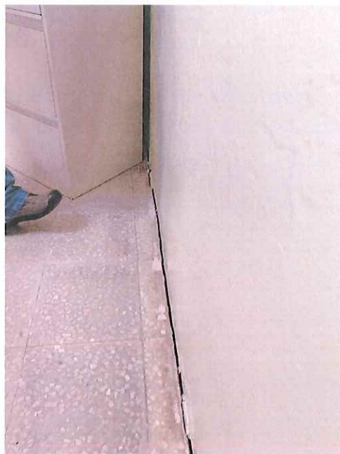
Fotos: Separación de loza de piso y pared y grieta en losetas.
