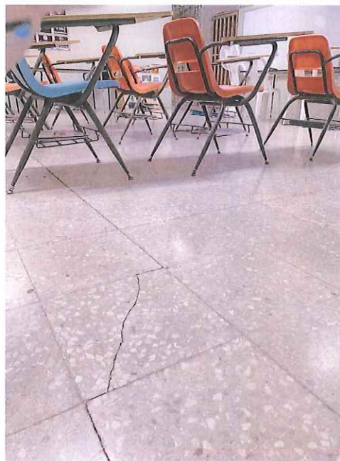
Fotos: Separación de loza de piso y pared y grieta en losetas.
